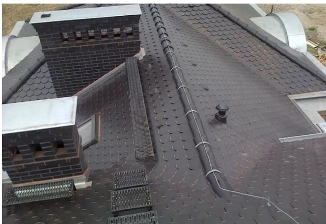
Фотосуретте Польшадағы шағын қалашықтағы күрделі шатырдың фрагменті көрсетілген. Алқап беткейлердің анық ішкі бұрыши болмайтындағы және бір-біріне тегіс ағып тұратындағы етіп жасалған.
