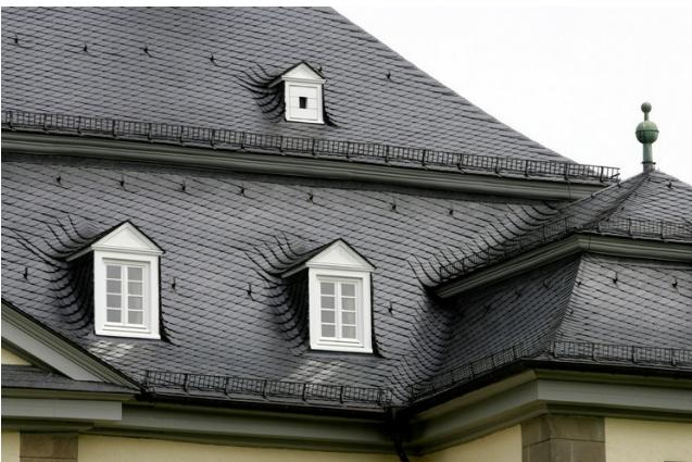
Фотосуретте шифер төбесі көрсетілген. Барлық қисықтардың қаншалықты керемет жасалғанын қараңыз. Төбесі айдаһар қабыршақтарымен жабылған сияқты. Бұл алқапты орнату жұмыстары жоғары бағаға лайық.
